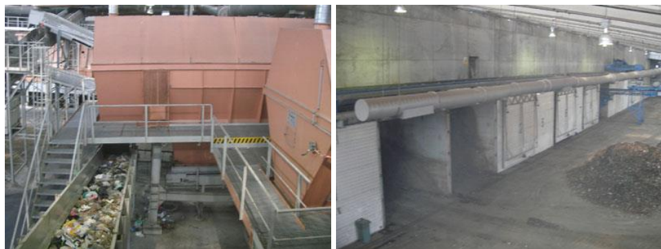
Obr. 11.12 Doprava do rotačného sita (vľavo) a tunel pre ZKO (vpravo).
