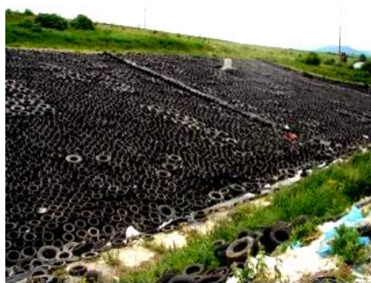
Obr. 7.14 Pohľad na izolačné vrstvy skládky.
